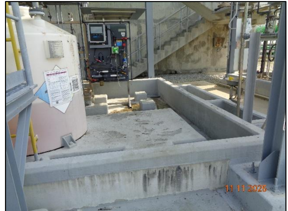
รูปที่ 2-31 คันกั้นป้องกันสารเคมีหกรั่วไหล (Dike)
