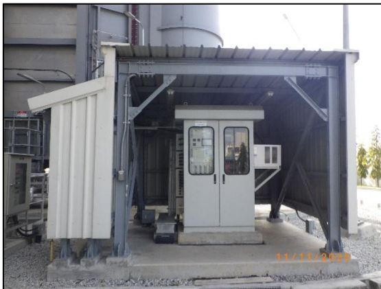
รูปที่ 2-3 เครื่องตรวจวัดคุณภาพอากาศ แบบต่อเนื่อง (CEMs)
